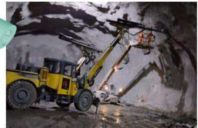
Escavação do Túnel: Método de perfurar e explodir
